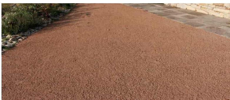
Parkové cesty budou řešeny mlatovým povrchem se zapuštěnými ocelovými obrubami.
