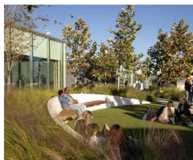
Lavičky se zádivou opěrkou jako opěrnou zdí svahu
