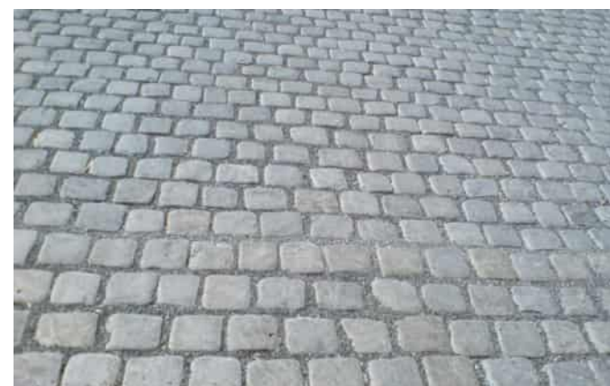
Zpevněné plochy budou provedeny z přírodních materiálů, nejlépe žulových kostek.
