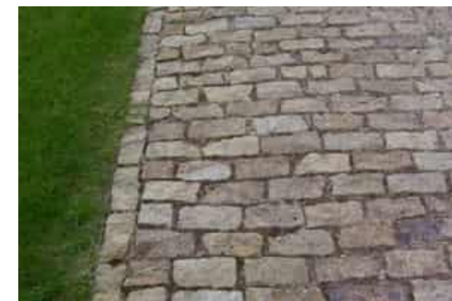
Zpevněné plochy budou provedeny z přírodních materiálů, nejlépe žulových kostek.
